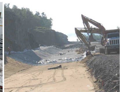
IMPERMÉABILISATION DE FOSSE
