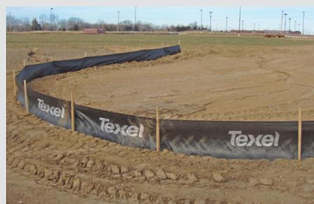
Peut être composée d'un géotextile tissé ou d'un non-tissé
