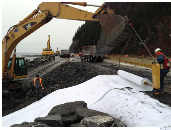
Figure 4 – Mise en place d'un géotextile en pente à l'aide d'un dérouleur
