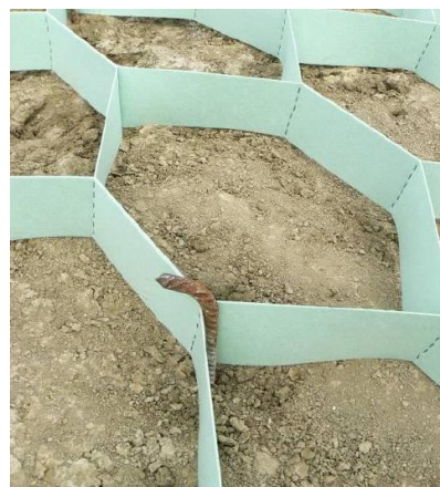
Figure 8 – Crampes sur GÉOCELL NT
