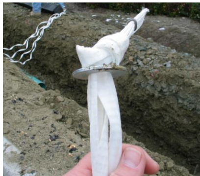
Figure 6 – Exemple de tendon avec rondelle
