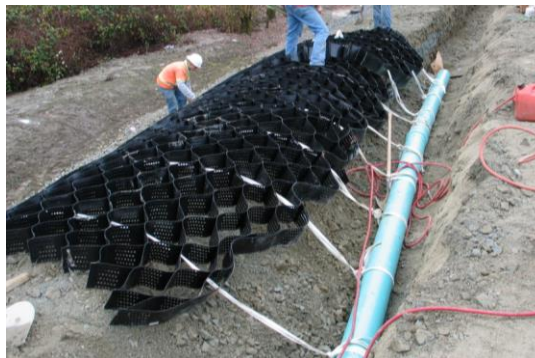
Figure 7 - Tendon attaché à un lestage
