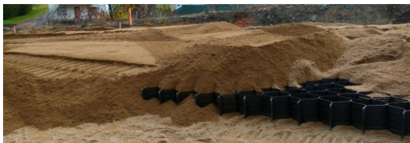
Figure 11 – Exemple de remblaiement du GÉOCELL PEHD à plat
