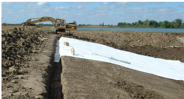
Figure 2 - Tranchée d'ancrage géomembrane TM600
