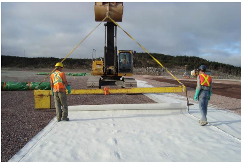
Figure 3 - Mise en place de la géomembrane TM600 à l'aide d'un dérouleur
