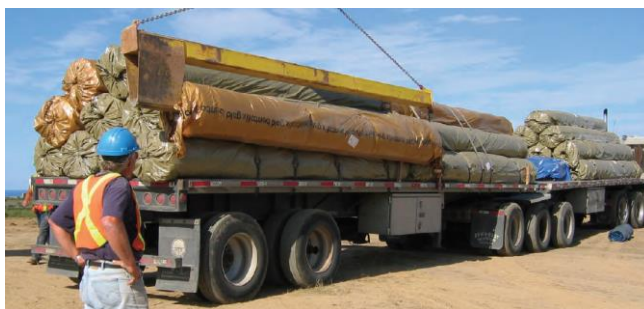
Figure 1 - Déchargement de géomembrane bentonitique
