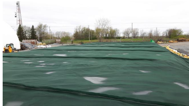
Figure 4 - Lestage avec barrière anti-vent
