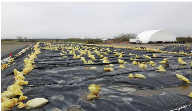
Figure 3 - Lestage avec sacs de sable
