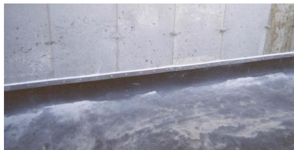
Figure 2 - Exemple d'ancrage au béton
