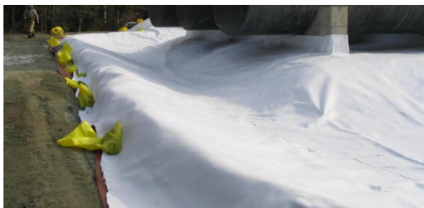
Figure 1 - Exemple de tranchée d'ancrage
