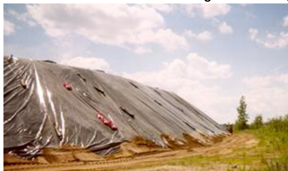
Figure 5 - Lestage avec sangles et remblai granulaire en périphérie
