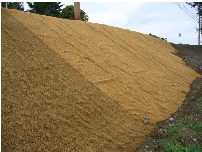
Figure 1: Matelas anti-érosion en coco tissé utilisé en protection de talus
