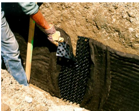
Figure 6: Emboîtement de deux panneaux de Soldrain 4000
