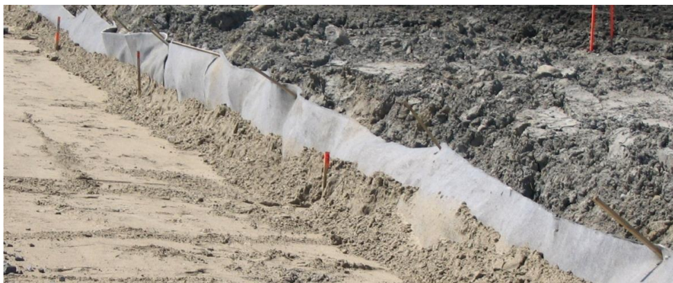
Figure 2 - Mise en place du TEXDRAIN 80 V, application routière
