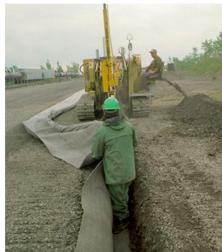
Figure 5 - Mise en place du TEXDRAIN 80V à l'aide d'une trancheuse
