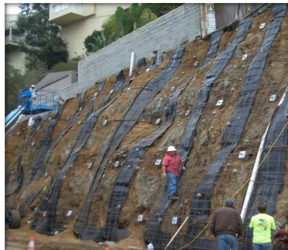
Figure 8 – Exemple de mise en place du TEXDRAIN 80H, application pour masque drainant sur paroi rocheuse
