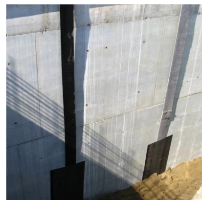
Figure 7 - Mise en place du TEXDRAIN 80H, application pour drainage de culée de pont
