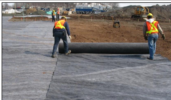
Figure 1 – Mise en place du Texel Géo-9
