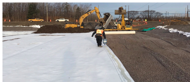
Préparation d'un chevauchement à l'aide de poudre de bentonite
