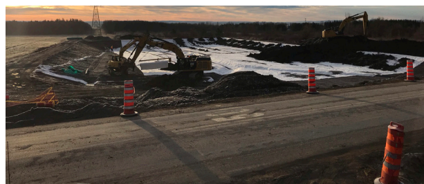
Mise en place de la membrane bentonitique Texel TM600 SRNW
