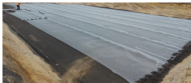
Installation de géogrilles NXST
