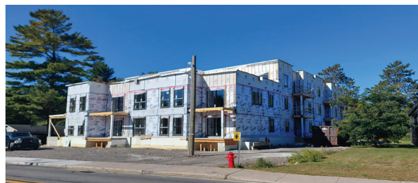
Bâtiment en construction
