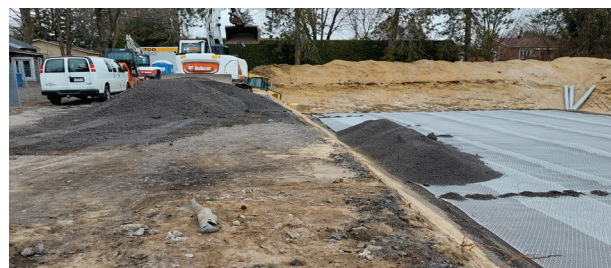
Mise en place du remblai sur la géogrille NXST
